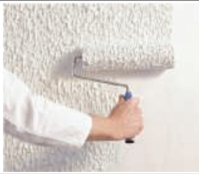
Auftrag von Capa-Rollputz mit der Erbslochwalze.
